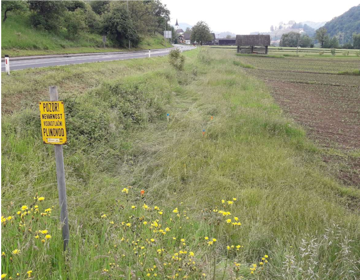
Slika 15: zakoličba prenosnega plinovoda R42 na stacionaži cca 12.945 m' (oranžni količki) in predvidenega vodovoda (modri količki); oranžno-modri količek je točka predvidenega križanja
